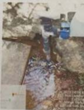
Imagem 2: Padrão de entrada de água com vazamento na tubulação.
