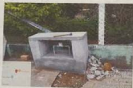
Imagem 13: : Retirada de tábuas de caixaria de abrigo de padrão de água.
