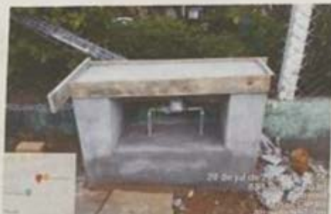
Imagem 12: Retirada de tábuas de caixaria de abrigo de padrão de água.
