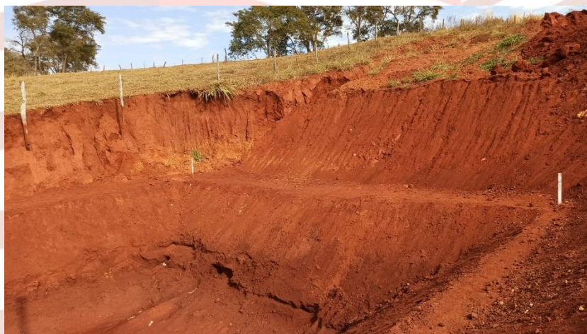
**Figura 2 – fotos de onde será construída a elevatória (EEE)
