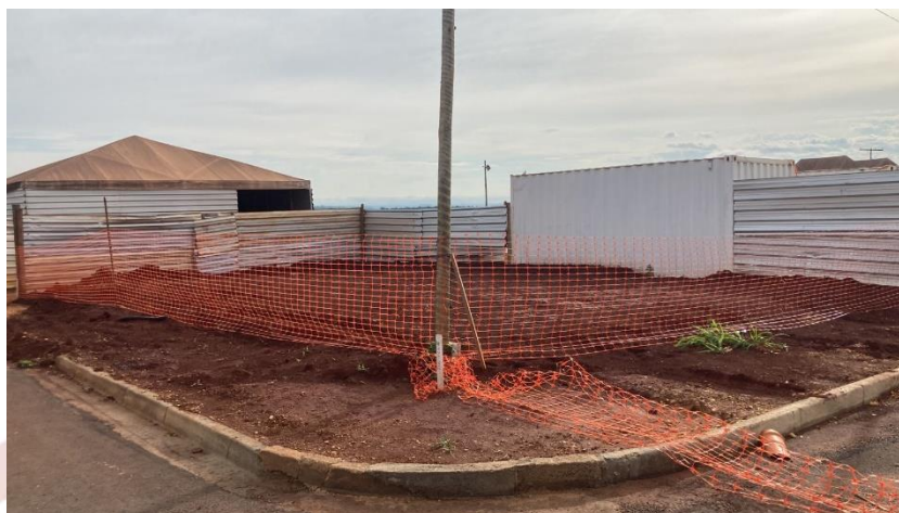
***Figura 3 – Terreno nivelado para construção da base do reservatório de 100m 3
